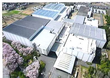
収集資料の保管施設
